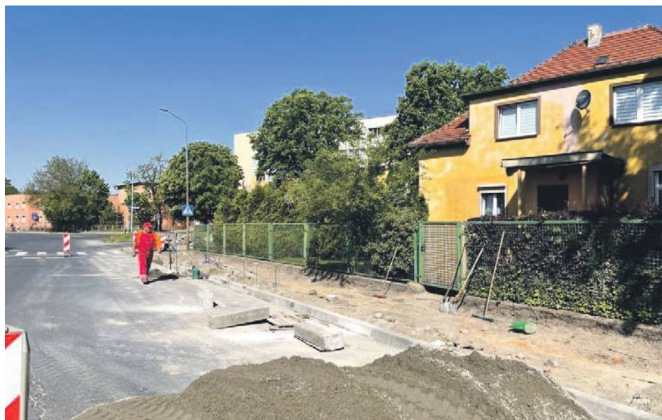
Budowa chodników już trwa
