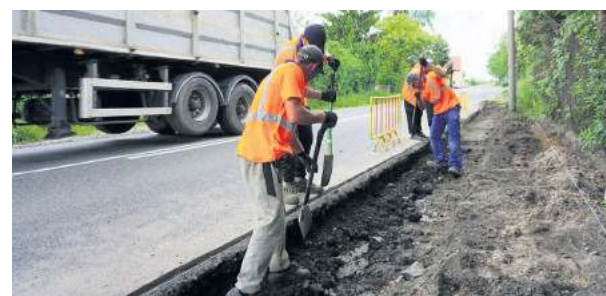
Ruszyła przebudowa drogi i budowa zatoki autobusowej
