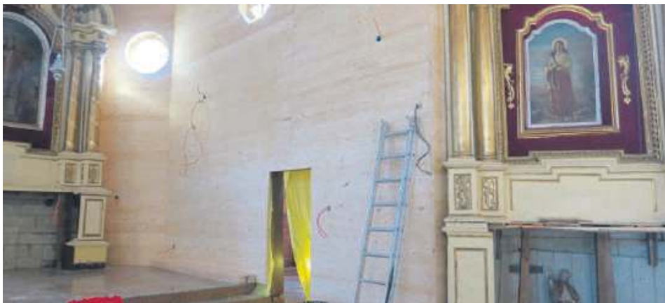
Kościół w Nieliszu przechodzi właśnie generalny remont.
