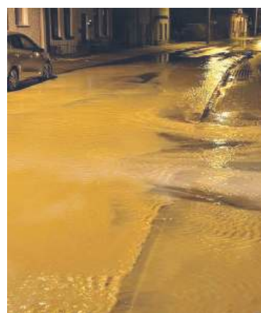
Awaria wodociągu na ul. Ogrodowej w Chełmie
