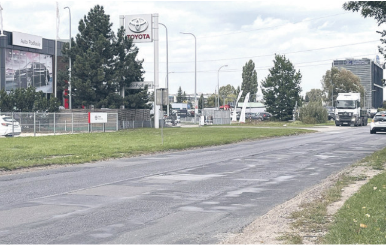
Remont Terespolskiej nie obejmie budowy wagi. fot. bs
