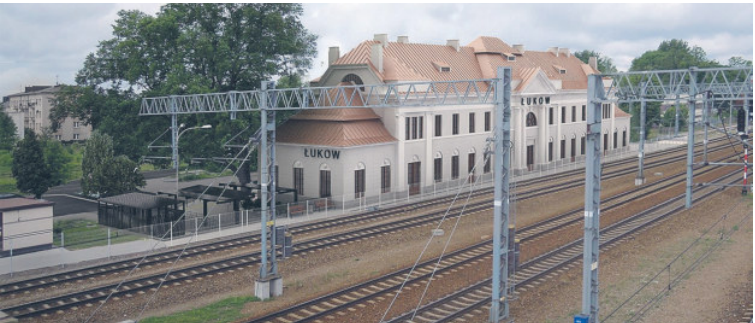
Budynek dworca przechodzi remont. Na modernizację stacji nie ma szans.
