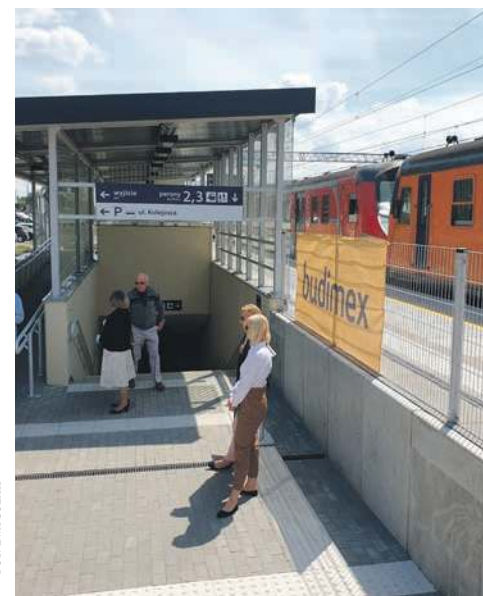
Zejsście do przejścia podziemnego
