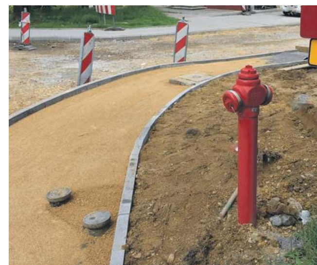
Wodociągi Chrzanowskie zakończyły inwestycję na ulicy Kościelnej
