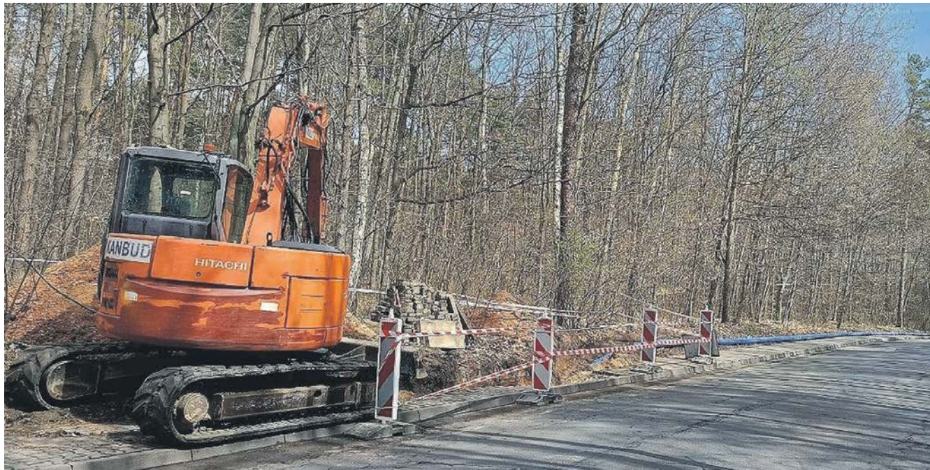
Rozbudowa sieci wodociągowej z Czyżówki
