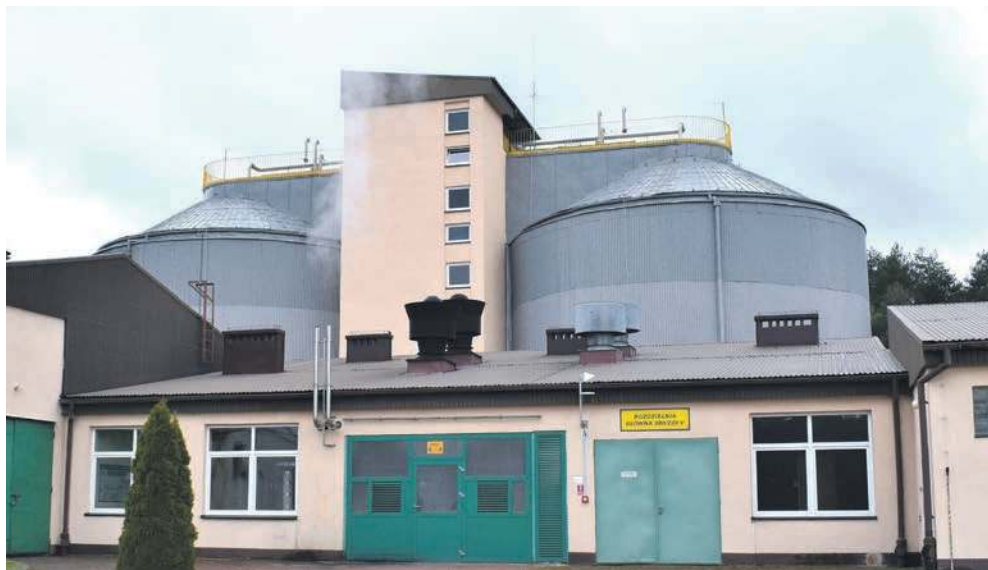
Biogazownia w Grupowej Oczyszczalni Ścieków w Chrzanowie działa już od ponad ćwierć wieku. Teraz Wodociągi Chrzanowskie planują budowę biogazowni na terenie oczyszczalni w Libiążu
