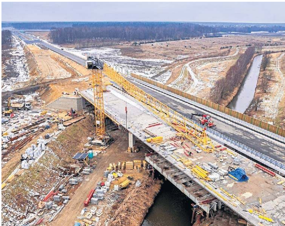
Budowa drogi S1 - Okolice Bijasowic i Zarzyny. Zdjęcia z lotu ptaka z 30 stycznia br. Pełne zakończenie prac na odcinku Bieruń - Oświęcim przewidziane jest na koniec roku
