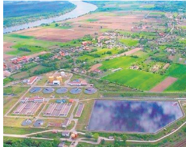
Bydgoska oczyszczalnia Kapuściska
