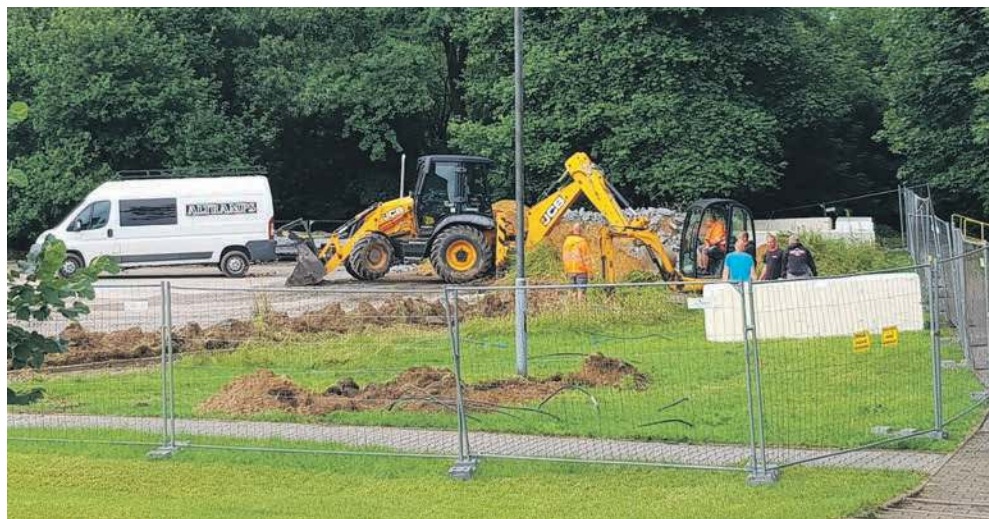
Na początek na placu budowy prowadzone są prace rozbiórkowe
