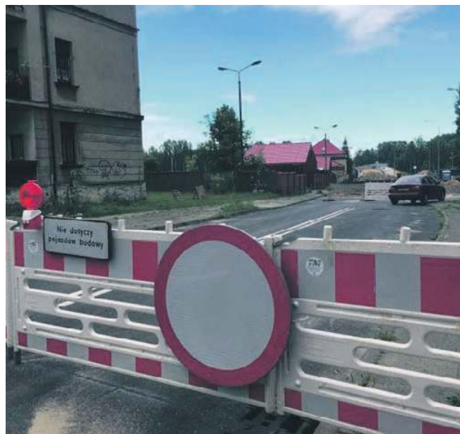
Budowa potrwa jeszcze półtora miesiąca
