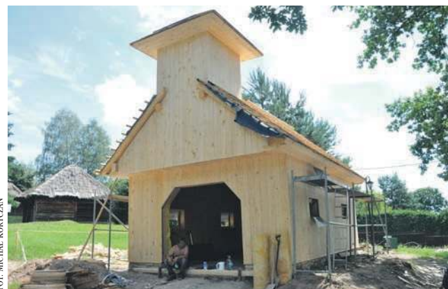
W skansenie powstaje remiza strażacka
