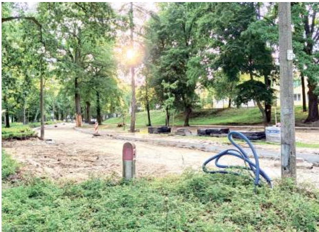
Nowe energooszczędne oświetlenie powstanie m.in. na ul. Kaniowczyków. Na razie nie zostały ustawione jeszcze nowe słupy z nowymi oprawami
