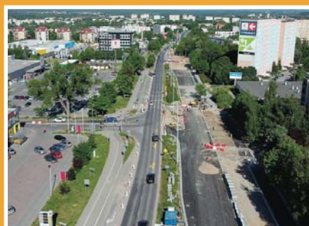
Remont ważnej ulicy w kierunku obwodnicy \4
