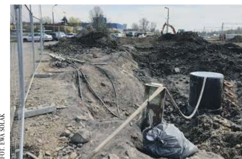
Prace budowlane przy stacji
