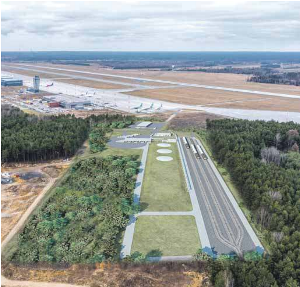
Rozpoczyna się budowa węzła przeładunkowego. Wszystko ma być gotowe w połowie 2026 roku FOT. MATERIAŁY PRASOWE/WIZUALIZACJA
