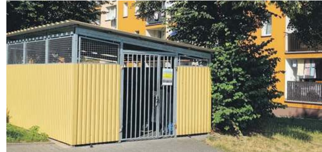
Przyblokowe stanowisko do składowania odpadów
