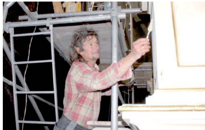
Trwają już prace przy ołtarzach bocznych
