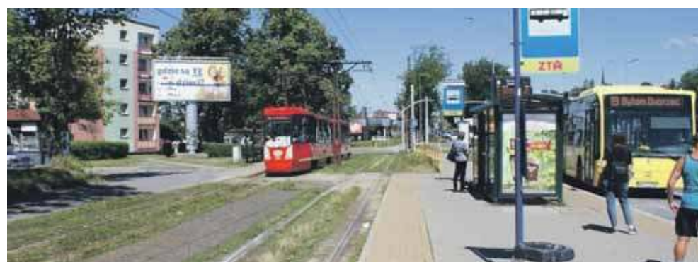
W Bytomiu-Stroszku trwają prace przy modernizacji torowiska
