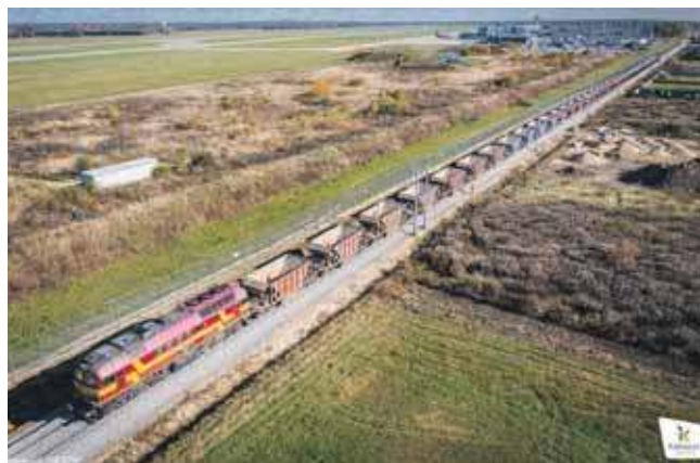
W drugiej połowie października na odbudowywanym fragmencie linii, na wysokości lotniska, przejechał skład techniczny z 38 wagonami samowyładowczymi z kruszywem
