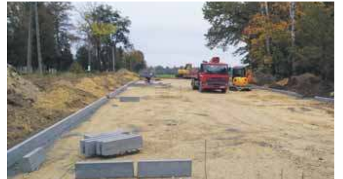
Rozpoczął się pierwszy etap prac przy budowie ścieżki przyrodniczej w Zbrosławicach
