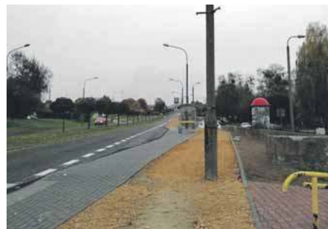
Taka niespodzianka na budowanej drodze rowerowej
