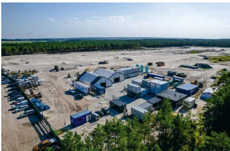
Miejsce budowy elektrowni atomowej w Słazszewie. 13 sierpnia 2025 r.
