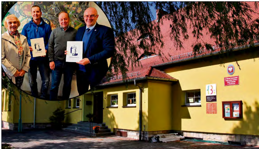
Remont przeprowadzi krapkowicka firma BUDOPAP.
