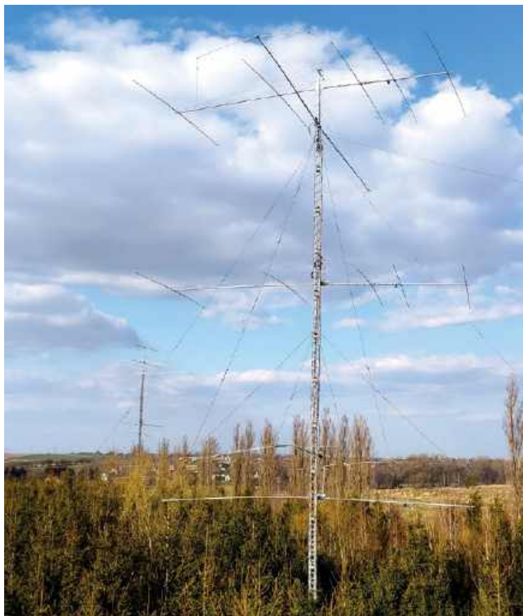
System antenowy stacji SP8R
