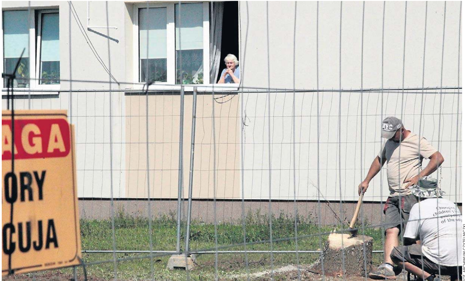
Po ogromnych tujach nie zostały nawet pieńki, kilku robotników krząta się po placu budowy.
