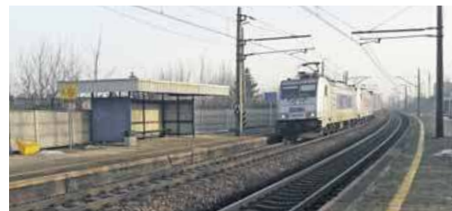
Na odcinku z Nakła Śląskiego do Chorzowa przebudowa obejmuje wymianę torów i sieci trakcyjnej na odcinku ponad 23 kilometrów, przebudowę pięciu stacji i dwóch przystanków, w tym Radzionków Rojca
