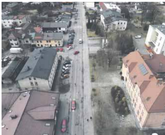
Jeszcze w tym roku zostanie przebudowana ul. 1 Maja i przed budynkami szkolnymi w Kaletach
