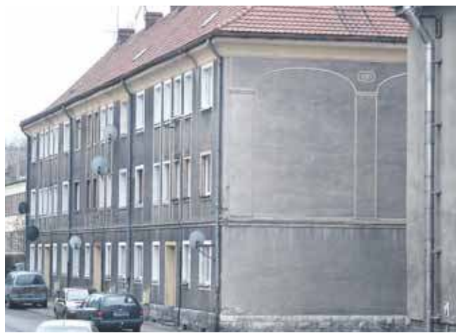
To już zdjęcie archiwalne jednego z budynków przy ul. Jana II Opolskiego w Tarnowskich Górach. Termomodernizacja skończyła się likwidacją gzymsów i innych przestrzennych zdobień
