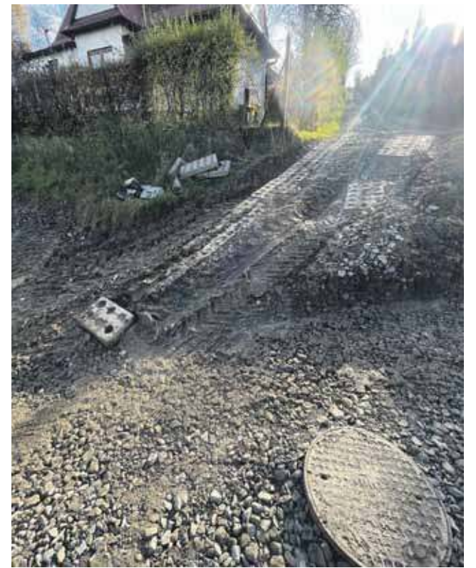
Niekończący się remont na ulicy Gorczańskiej.
