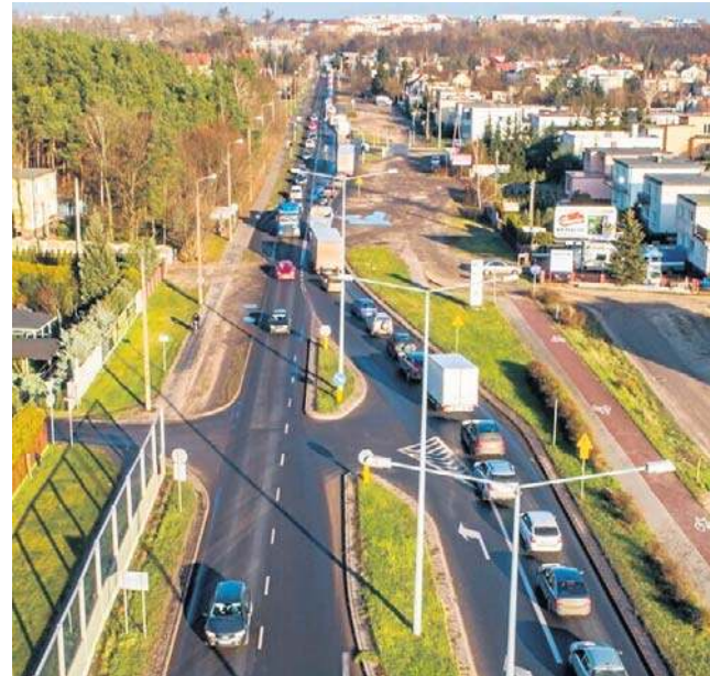
W efekcie przebudowy Olsztyńska będzie ulicą dwujezdniową - o dwóch pasach ruchu
