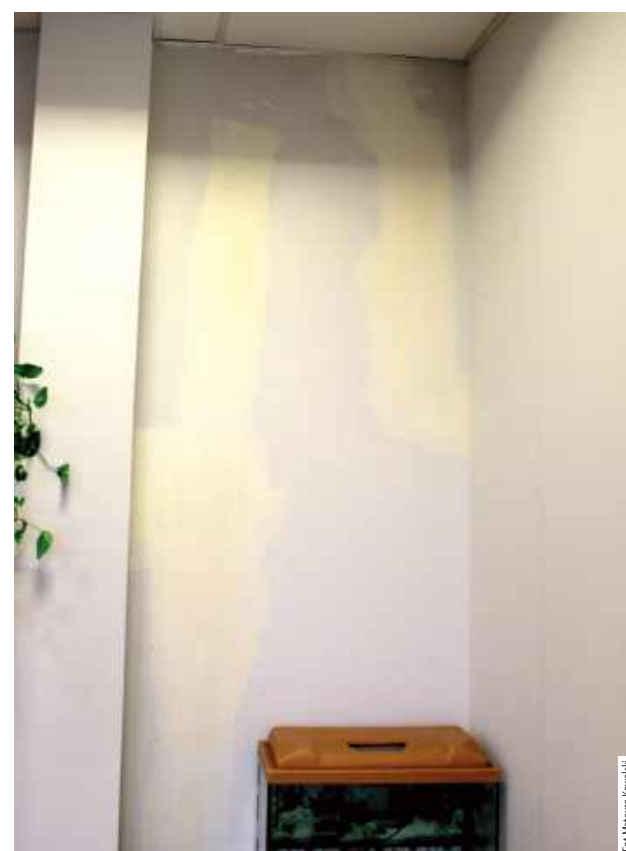
Takie ślady na ścianach w części sal lekcyjnych i innych pomieszczeniach szkoły to efekt zalamowania ich powierzchni po zaciekach wynikających z zalania
