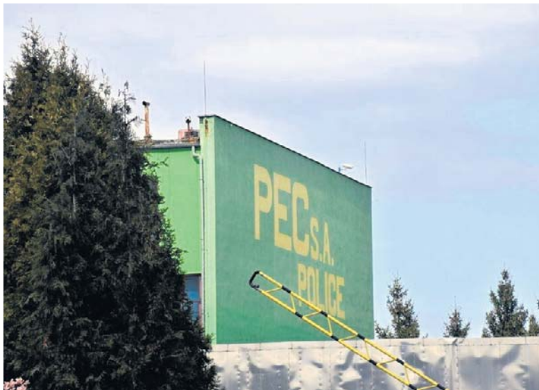
Inwestycja nie jest zakończona, odwiert wykonany.
