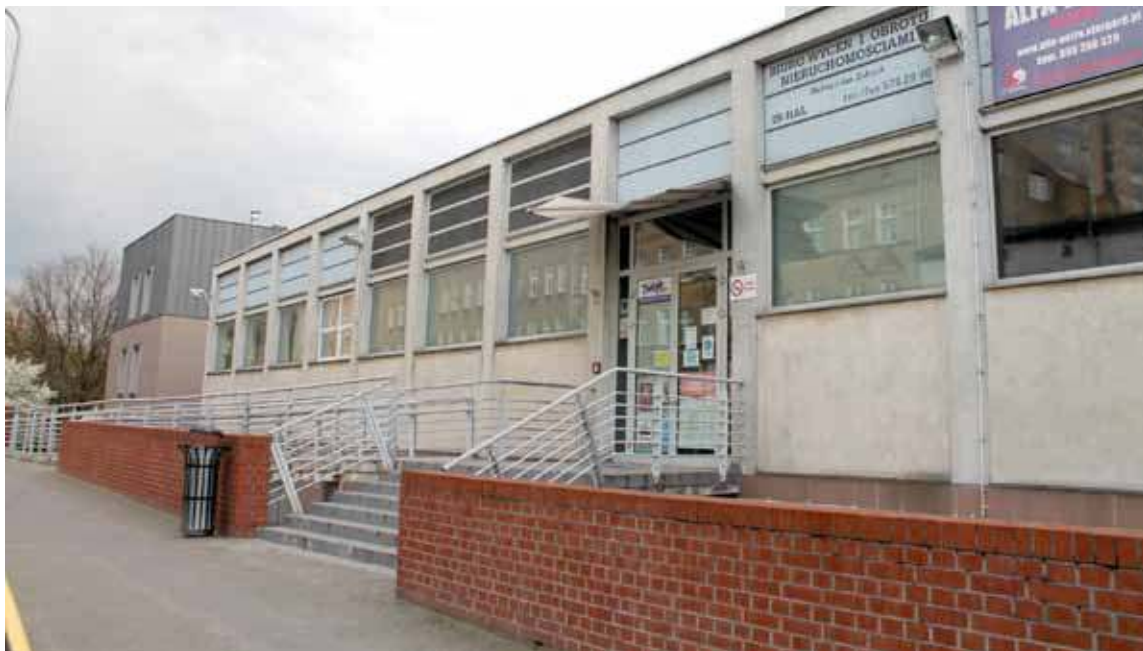
Punkt szczepień masowych będzie się znajdował w budynku SCK, wejście od strony Wojska Polskiego
