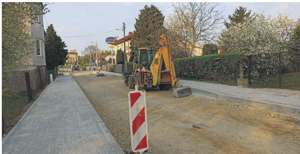
Prace na ul. Ochronkowej
