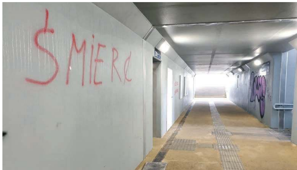
Przejście podziemne na stacji Chrzanów ul. Fabryczna
