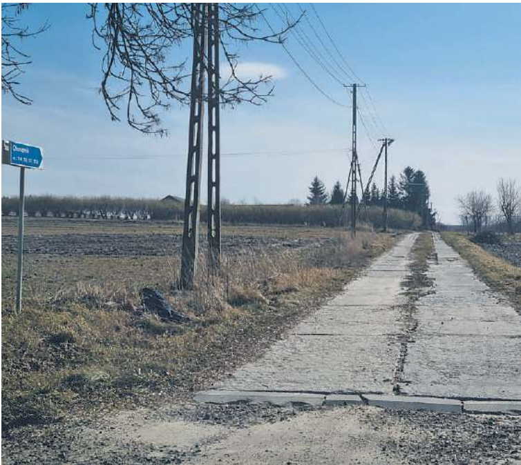
Tak obecnie wygląda droga w Chorupniku, o budowę której zabiega wiceprzewodniczący rady gminy Gorzków Radosław Parka
