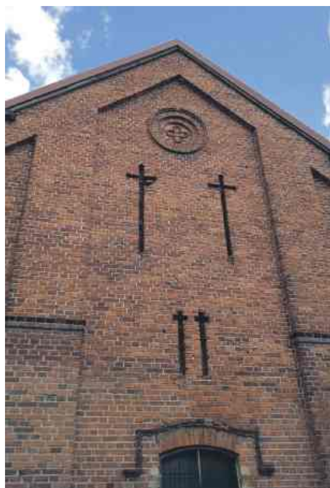
Detale na budynku folwarku.
