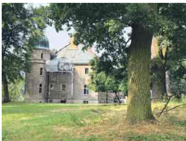
Pałac jest remontowany
