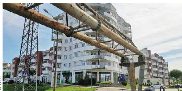
W Elblągu trwa modernizacja sieci ciepłowniczej
