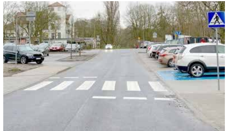
Zakończyły się prace przy ulicy Zielona Droga (fot. Gm. Goleniów)
