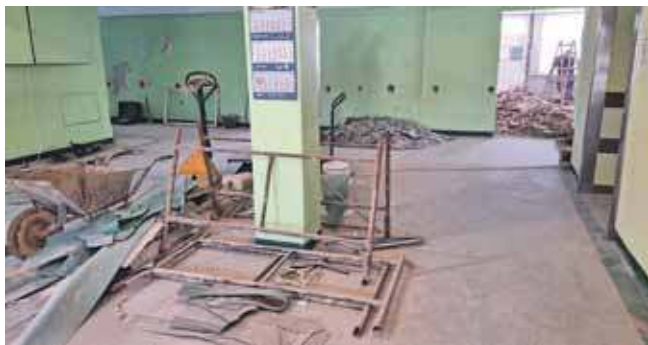
To dopiero początek remontu
