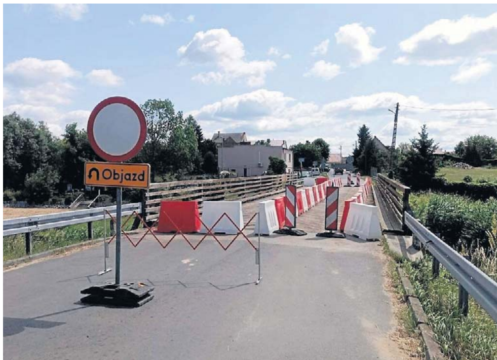
Po kilkutygodniowej przerwie remont mostu w Strzyżewie ma zostać wznowiony w połowie sierpnia. Zakończenie inwestycji zaplanowano obecnie na 30 listopada
