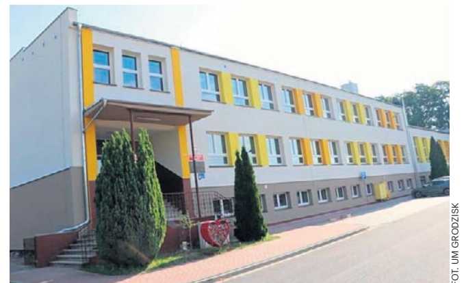
Tak prezentuje się budynek szkoły po remoncie
