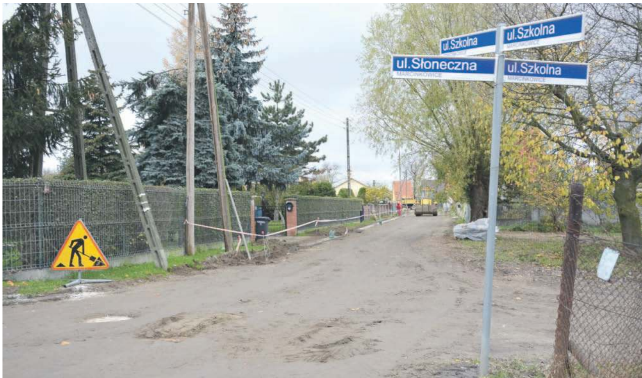
Asfalt na Szkolnej będzie tylko do skrzyżowania, bo dalej nie ma kanalizacji deszczowej
