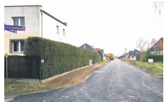
...a tak wygląda ulica Korczaka, objęta programem utwardzania dróg gruntowych mieszanką mineralno-asfaltową
