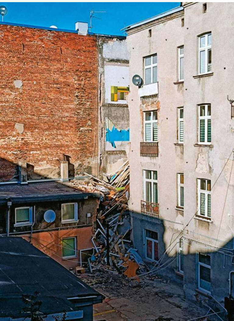
Łódź, Al. 1 Maja. Część kamienicy zawaliła się na skutek drążenia tunelu.
