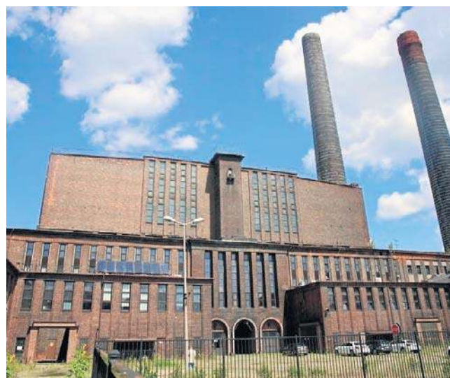
Najnowszy nabytek to Elektrociepłownia Zabrze
