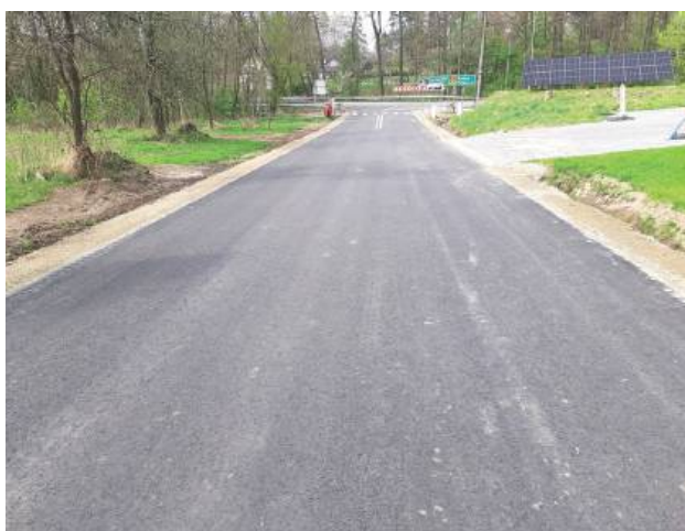
Od kilku dni mieszkańcy Sosnowa korzystają ze zmodernizowanego odcinka drogi
