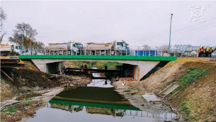
Most bez problemów zdał próbę obciążeniową
