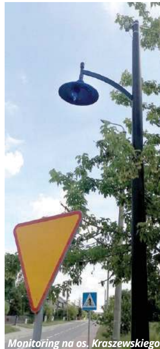
Monitoring na os. Kraszewskiego
