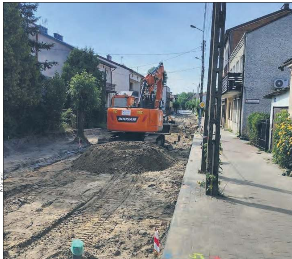
Wykonawcą robót jest firma Meliorant z Garwolina, która została wprowadzona na teren budowy 9 listopada 2022 roku. Jest zobowiązana wykonać umowę do 25 października tego roku
