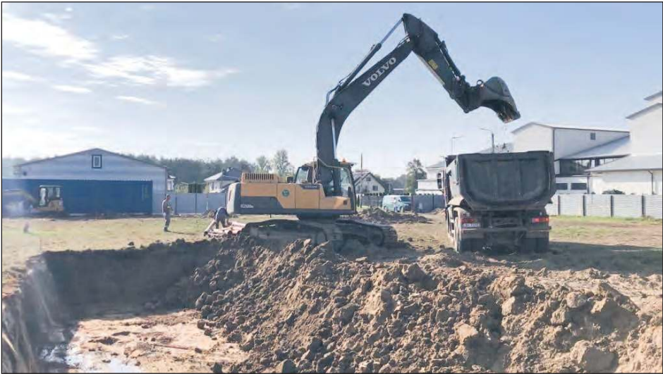
Pierwsze prace ruszyły 18 września. Wtedy rozpoczęły się wykopy pod fundamenty kościoła w Sulbinach. Zdj. Parafia św. Jana Pawła II w Sulbinach
