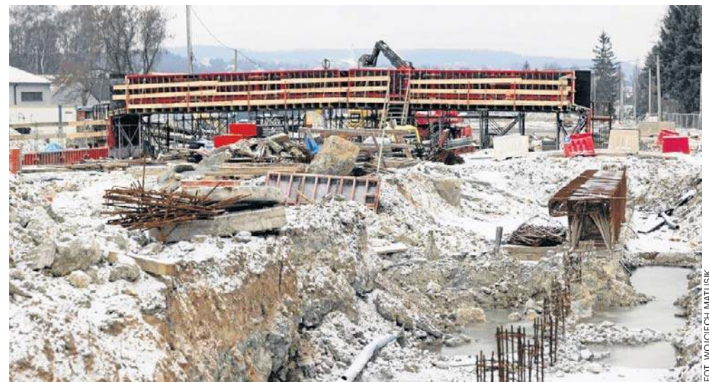
Budowa obwodnicy Zabierzowa w ciągu drogi krajowej nr 79
