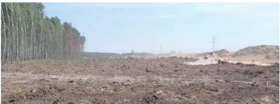
W okolicach Dobrynia trwa już przygotowanie terenu
