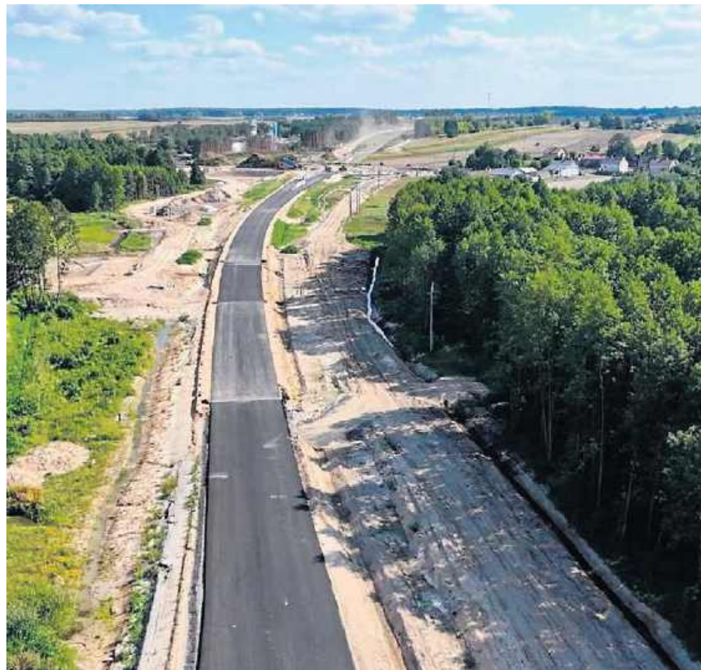
Budowa obwodnicy Ciepeliowa. Powstają kolejne fragmenty nowej trasy i skrzyżowania.
