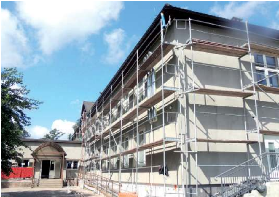
Choć wykonawca ma siedem miesięcy na zakończenie wszystkich prac, to na początek sierpnia inwestycję wykonał już w ponad 60 procentach
