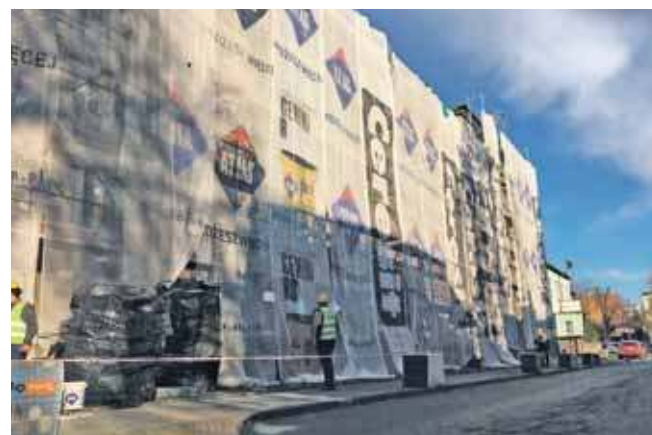
Budynek przy ul. Karłuszowiec był ocieplany ponad 20 lat temu, w 2000 roku
