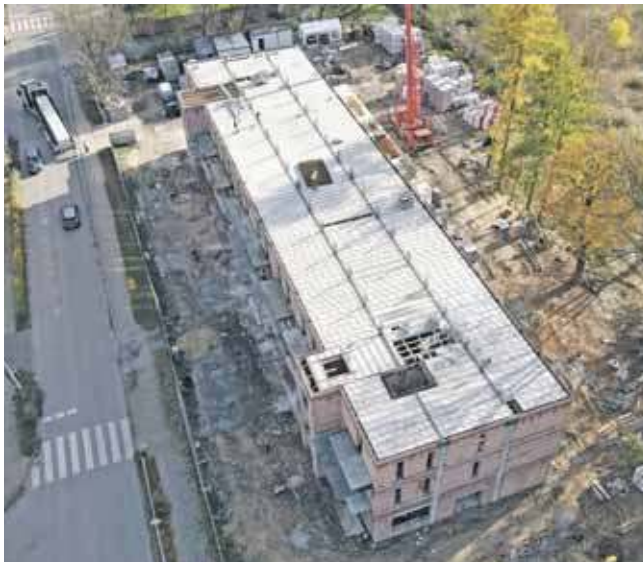
Obiekt przy ul. Kościelnej w Strzybnicy buduje firma Hydratec z Białegostoku
