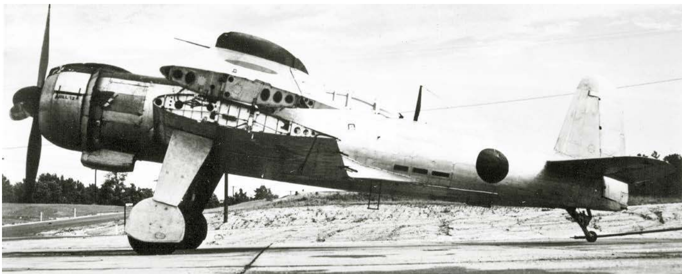
Zdobyczny B6N2 po przywiezieniu do Stanów Zjednoczonych. Jest to najprawdopodobniej egzemplarz znaleziony na Filipinach. Maszt antenowy na kadłubie to dzieło amerykańskich techników, którzy zamontowali amerykańską radiostację.
