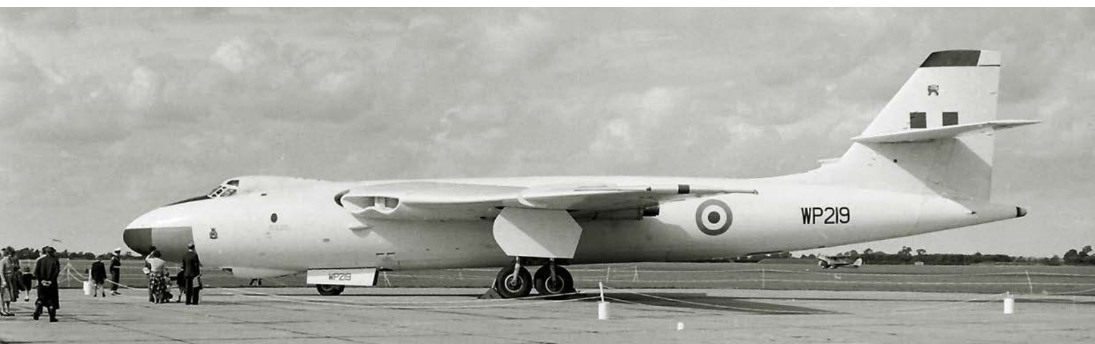
Valiant B(PR).1 (WP219) z No. 207 Squadron. Ta wersja powstała zamiast proponowanego przez Vickersa wyspecjalizowanego samolotu rozpoznawczego. W komorze bombowej i w kadłubie mogła przenosić do 12 aparatów fotograficznych. Zbudowano 11 egz. B(PR).1.
