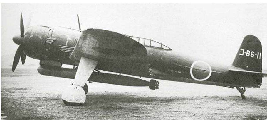
Prototyp B6N2 podczas prób w Wydziale Prób w Locie Arsenatu Techniki Lotniczej Marynarki Wojennej w bazie Oppama koło Yokosuki. Samolot ma już cienie indywidualne rury wydechowe z cylindrów oraz radar. Na jednym ze zdjęć widać wychylone klapy Fowlera o charakterystycznym kształcie.
