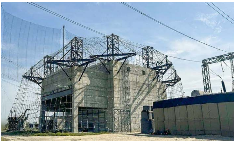
Jedna z ufortyfikowanych przed rosyjskimi atakami ukraińskich podstacji elektroenergetycznych.
