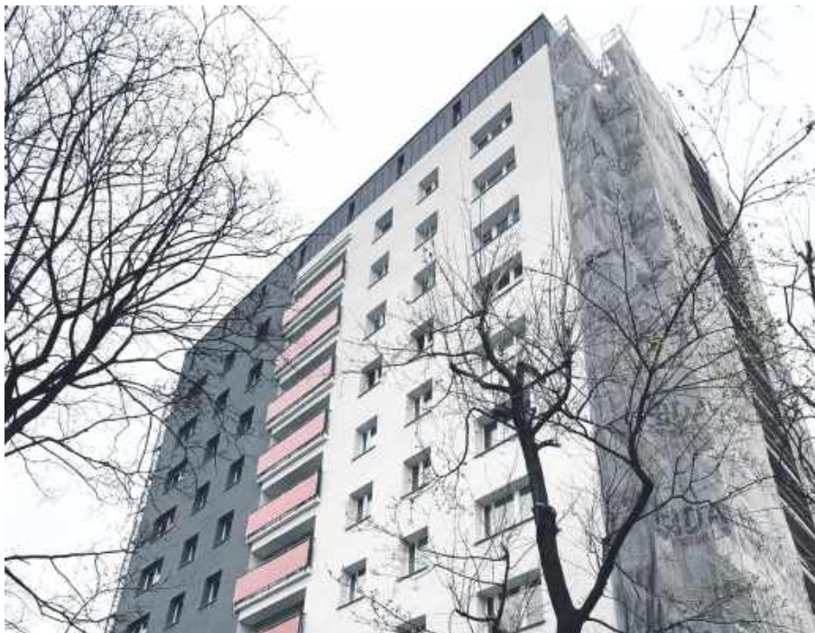
Efekty termomodernizacji wieżowca przy Szkolnej 10 robią wrażenie
