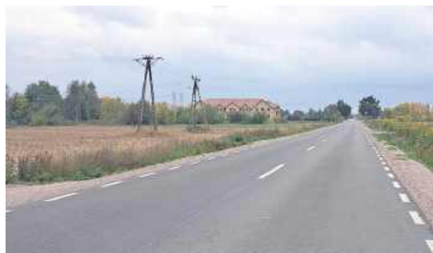
Jedną z oddanych do użytku dróg jest odcinek biegnący przez Zaścianki
