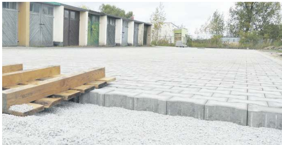
Przebudowa drogi pomiędzy garażami na osiedlu w Przewornie będzie kosztować budżet gminy 88 686,00 zł
